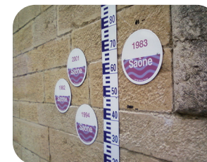
Repères de crues à Trévoux © EPTB
