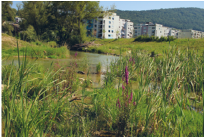
Fig. XI.3.11 À gauche : l'élargissement du lit et les berges en pente douce permettent le développement de zones d'interface généreuses. Au centre : l'espace et la nouvelle morphologie des berges favorisent l'accès à l'eau mais nécessitent la construction de nouvelles passerelles qui enjambent la totalité de l'espace cours d'eau, à l'exemple ici de celle du Haut Fourneau. À droite : aménagement de risbermes et structuration du lit, dans les secteurs les plus contraints par le manque d'espace à disposition. Photos : P.-A. Frossard
