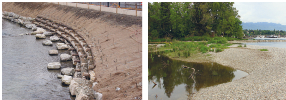
Fig. XI.3.4 À gauche: sur les tronçons les plus contraints en raison d'un faible espace disponible, les murs en béton ont été remplacés par des ouvrages de type caisson en rondins et le lit mineur a été enrichi en structures. À droite: vue de l'embouchure restaurée.
