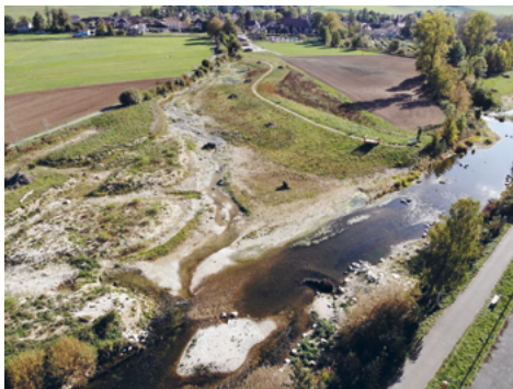
Fig. XI.4.7 À gauche : expression de la dynamique alluviale au niveau de la confluence Bied de Môtiers- Areuse. À droite : structuration du lit et aménagement de terrasses inondables en berge droite de l'Areuse Une digue anti-crue délimite l'espace d'influence du cours d'eau. Photos : Biotec Biologie appliquée SA
