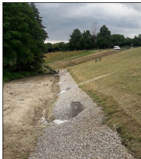
Travaux réalisés au droit du barrage (ici, drain aval en pied du barrage et puits amont en enrochement bétonné)
