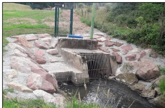
Travaux réalisés au droit du barrage (ici, drain aval en pied du barrage et puits amont en enrochement bétonné)
