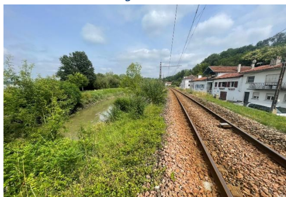
Figure 89. Remblai ferroviaire faisant office de digue à Urt
