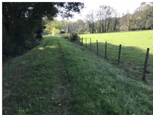
Figure 78. Photo d'un tronçon de la digue de Gurgues-Ingous de classe C
