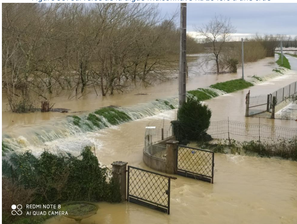
Figure 95. Surverse de la digue Maisonnave RD10 lors d'une crue
