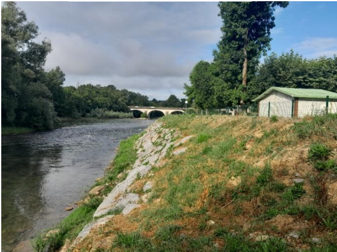
Figure 99. Digue de Sauveterre-de-Béarn
