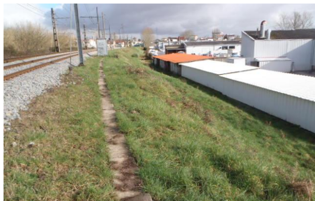
Figure 88. Remblai ferroviaire faisant office de digue à Dax
