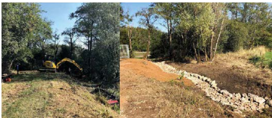
Sortie de l'étang des Alaine avant et après travaux en période sèche
