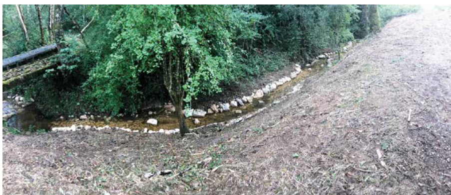
Reméandrement du ruisseau des grands Terreaux
