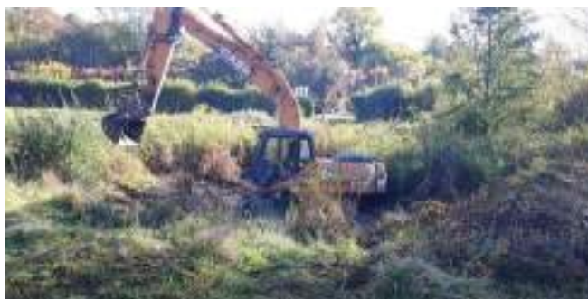
Photo de la mare en cours de curage
