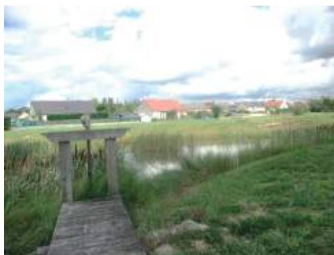
Ouvrage hydraulique recueillant temporairement les eaux pluviales à Pigny aménagé pour l'accueil de la biodiversité.
