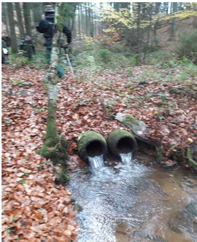
↑ Figure 6 et 7. Ruisseau du Ruxelier (Forêt Communale de Cheniménil - 88). Le calibrage des ouvrages de franchissements est nécessaire pour limiter l'obstruction, faciliter l'entretien et limiter la fragmentation des habitats. Ici, des travaux ont été réalisés pour effacer ces problématiques. L'ouvrage de gauche (deux tuyaux bétons de diamètre 500 mm sous dimensionnés) a été remplacé par l'ouvrage de droite (une demi-buse PEHD de diamètre 1000 mm). La buse coupée en deux dans le sens de la longueur permet de limiter l'effet de tourbillon qui empêche la formation d'un lit.
