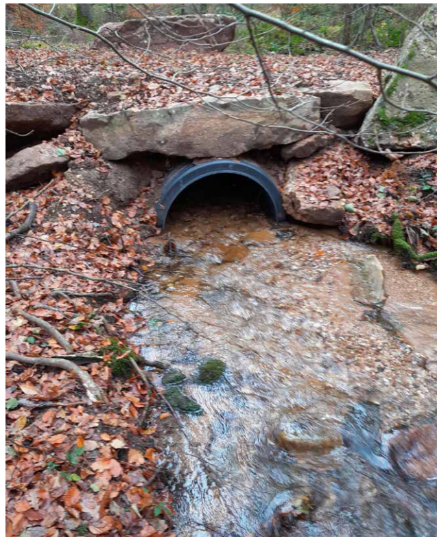
↑ Figure 6 et 7. Ruisseau du Ruxelier (Forêt Communale de Cheniménil - 88). Le calibrage des ouvrages de franchissements est nécessaire pour limiter l'obstruction, faciliter l'entretien et limiter la fragmentation des habitats. Ici, des travaux ont été réalisés pour effacer ces problématiques. L'ouvrage de gauche (deux tuyaux bétons de diamètre 500 mm sous dimensionnés) a été remplacé par l'ouvrage de droite (une demi-buse PEHD de diamètre 1000 mm). La buse coupée en deux dans le sens de la longueur permet de limiter l'effet de tourbillon qui empêche la formation d'un lit.
