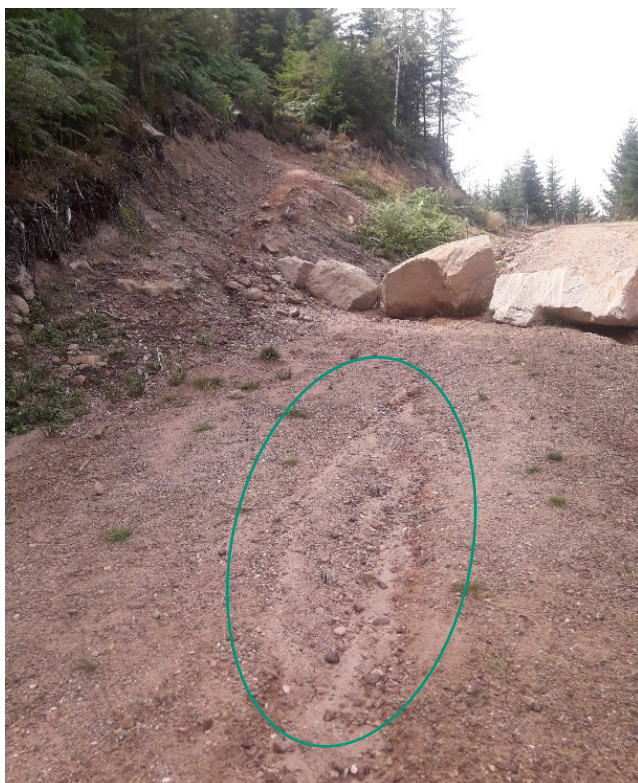
↑ Figure 2. Une desserte contributive à l'érosion : présence de griffes d'érosion, pente de 50% - distance entre deux collecteurs : 50 m (Route forestière de Nayemont - 88)
