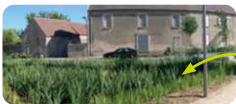
Création d'un bassin à l'emplacement d'une ancienne mare
