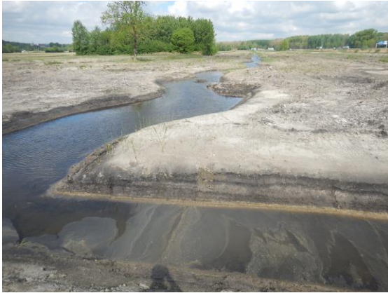
Figure 26 : Remodelage topographique dans une zone humide alluviale de l'Isle Crémieu (Isère).
