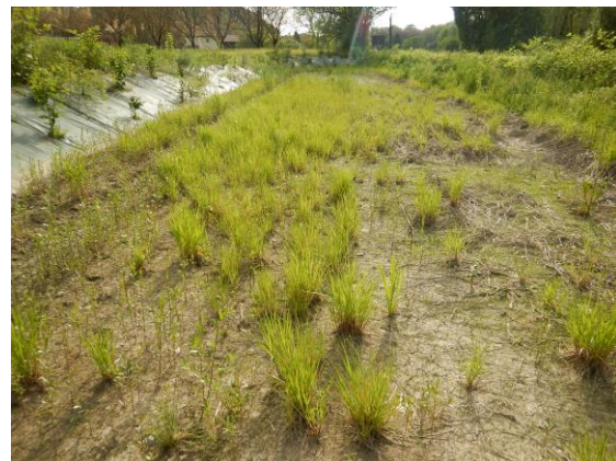
Figure 66 : Création d'une zone humide alluviale par excavation et plantation d'une haie avec un film plastique au sol dans un secteur de plateau dans le Grésivaudan (Isère). Aucun travail du sol après l'excavation n'a été réalisé, il n'est donc pas favorable à l'enracinement des végétaux.
