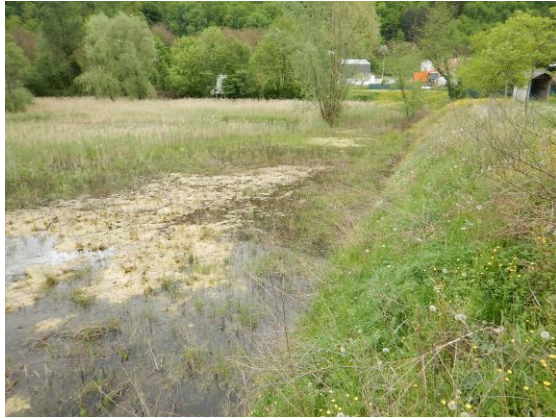
Figure 63 : Déblaiement excessif d'une zone humide alluviale dans le Grésivaudan (Isère). Un suivi sur le long terme permettrait de vérifier l'atterrissement progressif et l'apparition effective de zone humide.
