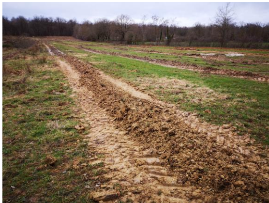
Figure 10 : Chantier récent de drainage souterrain dans une zone humide de plateau en Bresse (Ain).
