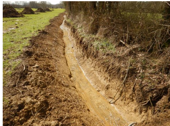
Figure 11 : Curage d'un fossé de drainage dans une zone humide alluviale en Bresse (Ain).
