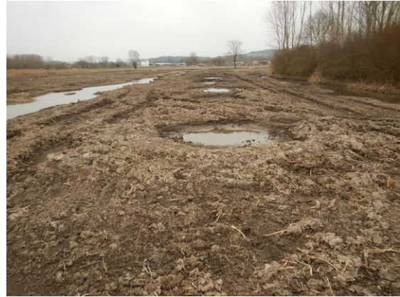
Figure 27 : Remodelage topographique dans une zone humide alluviale de l'Isle Crémieu (Isère).
