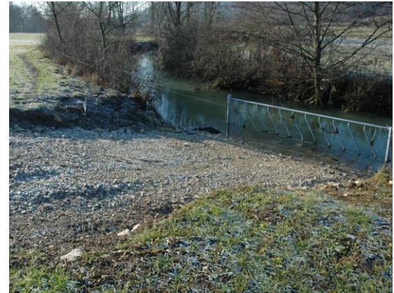
Figure 29 : Aménagement de dispositif pour abreuver le bétail et mise en défens de la berge sur une zone humide alluviale du Revermont (Ain).
