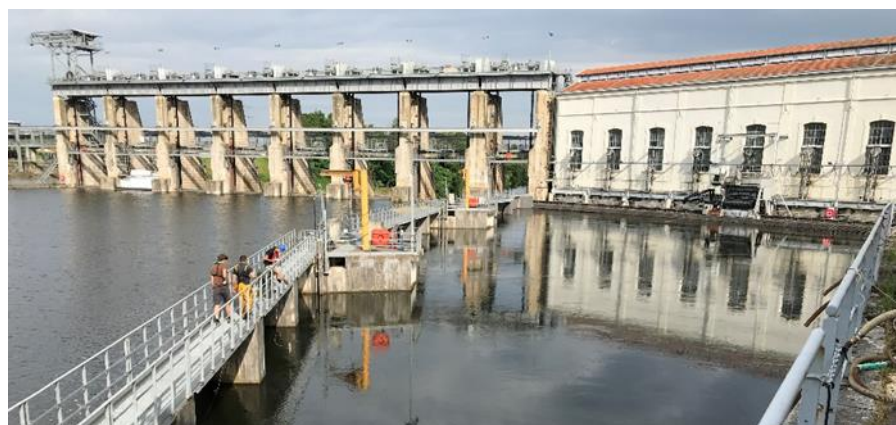
Relève des cordeaux dans la chambre d'eau de Tuilières
