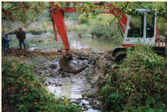
3- creusement des fondations, enlèvement de l'ancien ouvrage et des vases à l'aval du batardeau (octobre 1998).
