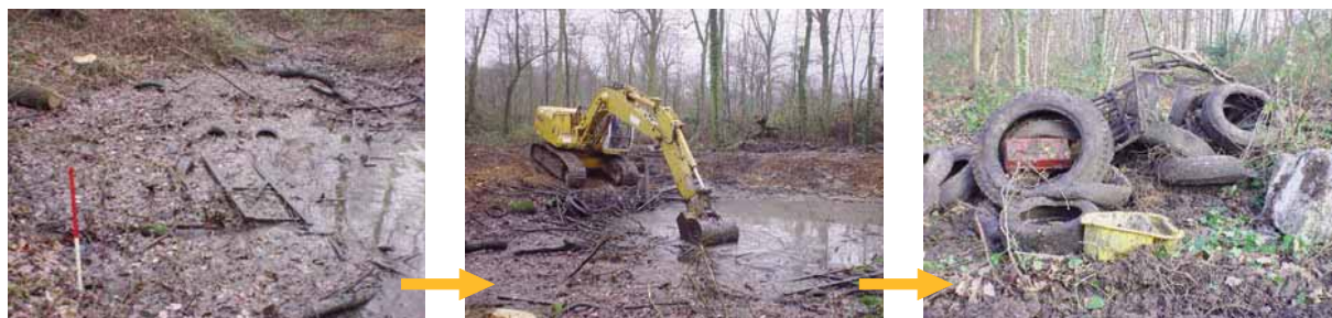
Dépollution d'une mare par curage. L'évacuation des déchets entraîne un surcoût des travaux : transport en déchetterie
