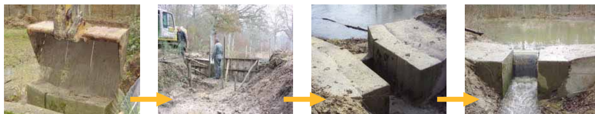
Renforcement d'un ouvrage de régulation des niveaux d'eau
