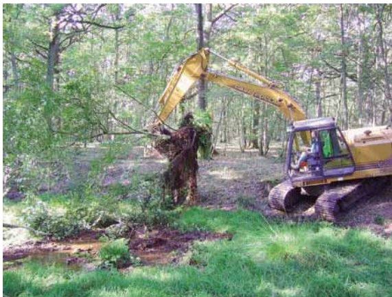
Arrachage d'un bouleau à la pelle mécanique. La tourbe subaquatique, contenue sous le bouchon de glycérie et de bouleau apparaît en brun sur la photo.
