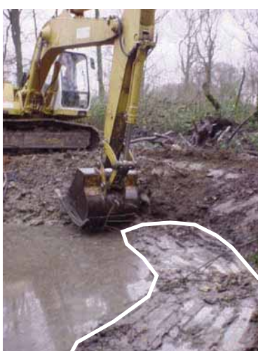
Banquettes en cours de création
