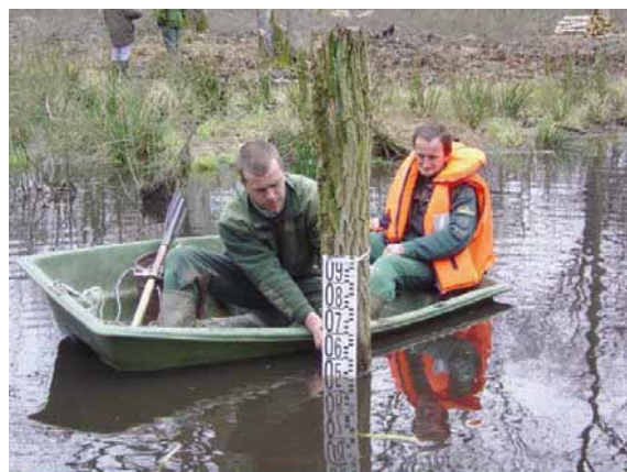
Installation d'une mire limnimétrique par les ouvriers forestiers
