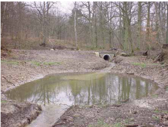
Bassin de sédimentation venant d'être créé, à l'occasion de la réfection d'une allée forestière. Les dépôts de sédiments en amont du bassin sont bien visibles
