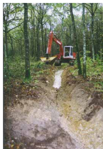
A gauche : décapage d'un fossé bouché par la Molinie, au moment du curage de la mare (en arrière plan). A droite : mise en eau d'un collecteur créé pour alimenter une mare. L'eau est détournée du fossé de drainage de parcelle qui passe à 30 m de la mare
