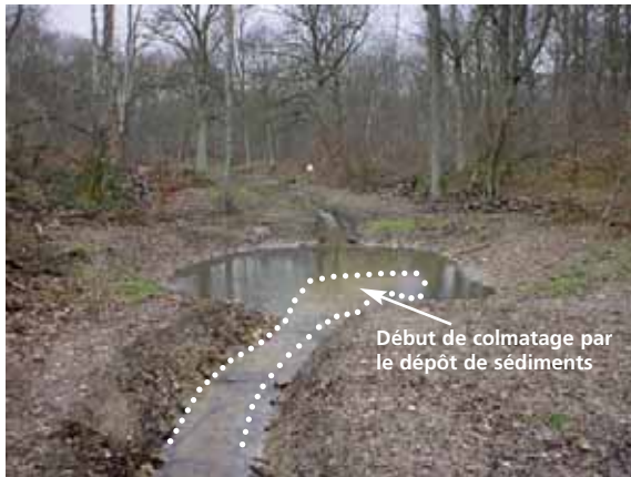
Février 2003, 4 mois après le creusement du bassin.
