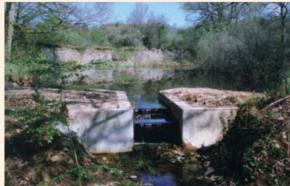
6- L'ouvrage est terminé. Le batardeau est enlevé et permet de remblayer et de compacter la digue. Les planches sont en place.
