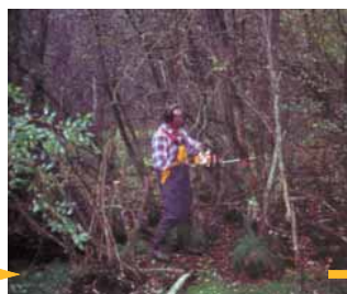
Octobre 1999 : travaux d'abattages localisés, en période d'exondation.
