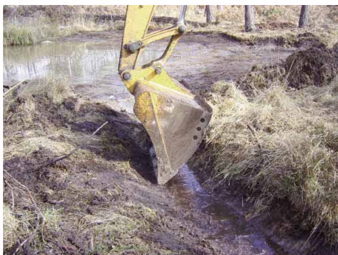
A gauche : décapage d'un fossé bouché par la Molinie, au moment du curage de la mare (en arrière plan). A droite : mise en eau d'un collecteur créé pour alimenter une mare. L'eau est détournée du fossé de drainage de parcelle qui passe à 30 m de la mare
