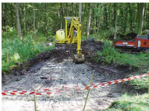
Curage de glycérie lors de l'assèchement complet de la mare. La zone est surcreusée jusqu'à l'apparition des gleys (en gris) qui forment le vieux fond.
