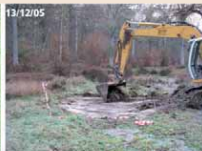
Décapage en période d'assèchement : la végétation et le substrat organique (en marron) sont enlevés jusqu'à l'apparition du fond minéral (en gris)
