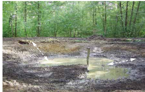
Curage terminé : aperçu des différentes profondeurs et des profils de berges
