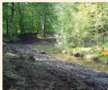
Une semaine après les travaux (13 septembre 2005)
