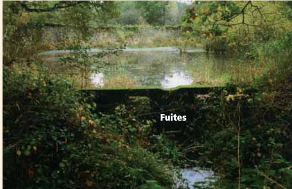
1- Etat initial, la digue et le déversoir sont recouverts par la végétation. La mare présente un aspect bucolique.
