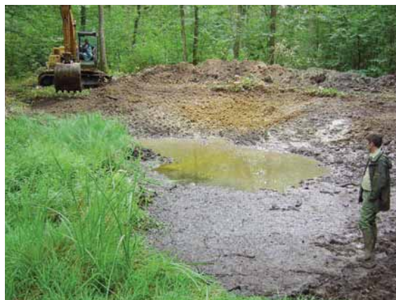
La présence continue sur le chantier d'un agent ou d'un technicien est indispensable lors des travaux de curage d'une mare.
