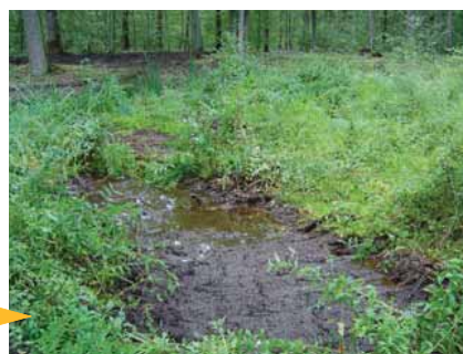
Etrépage terminé, réalisé à 10 cm de profondeur (06/09/05)
