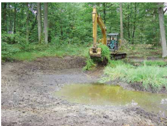
Curage de la glycérie et des saules, diversification des profondeurs et des pentes
