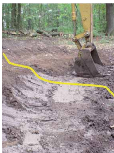
Banquettes en escaliers
