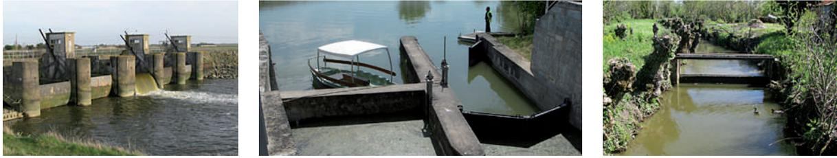
Illustration des typologies d'ouvrages en marais (clapet, écluse, batardeau)
