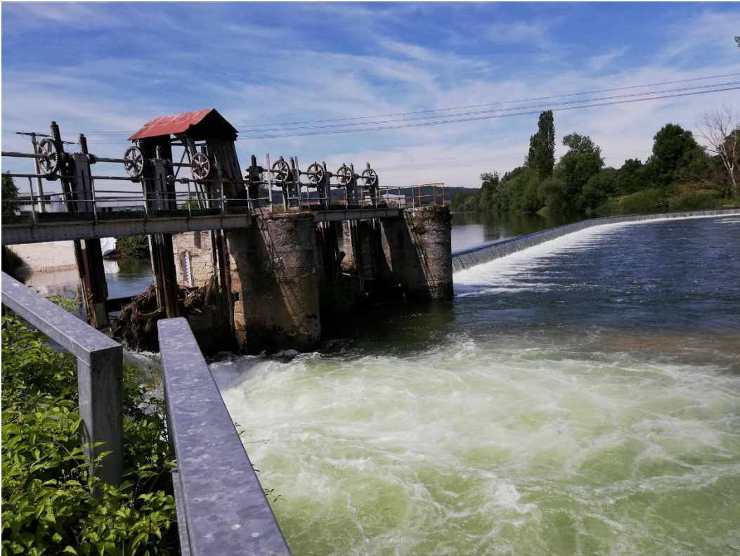
Seuil de Beaulieu avant arasement © EPTB Saône et Doubs
