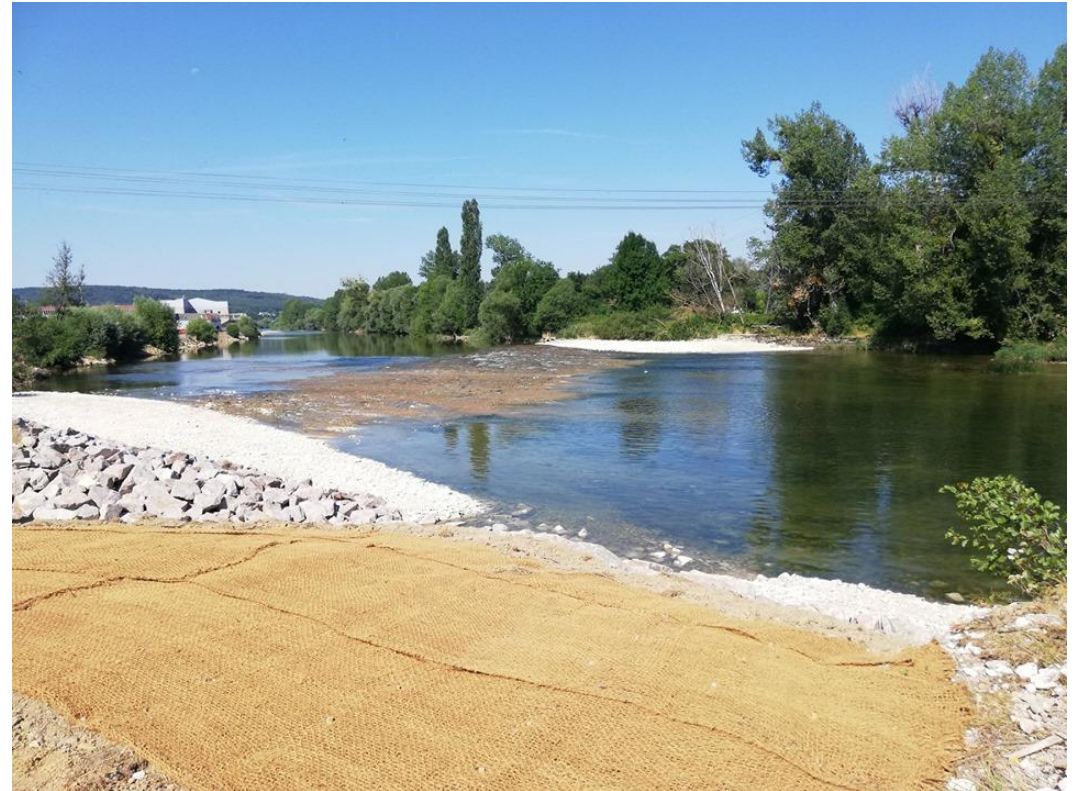
Seuil de Beaulieu après arasement et restauration de berges avec des techniques végétales © EPTB Saône et Doubs
