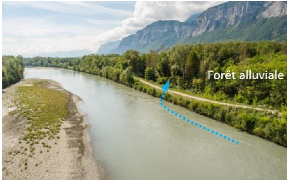
Connexion de la forêt alluviale de l'Isère par effacement ponctuel des digues historiques © SYMBHI
