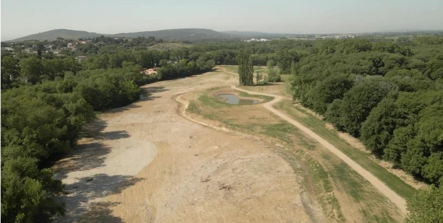
Prairie alluviale en cours de travaux de restauration, avec création d'une mare et d'une annexe hydraulique © SYBLE
