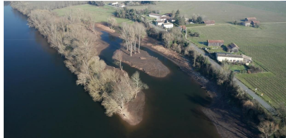
Réouverture du bras mort des Carretiers, résultat après travaux © EPTB Dordogne
