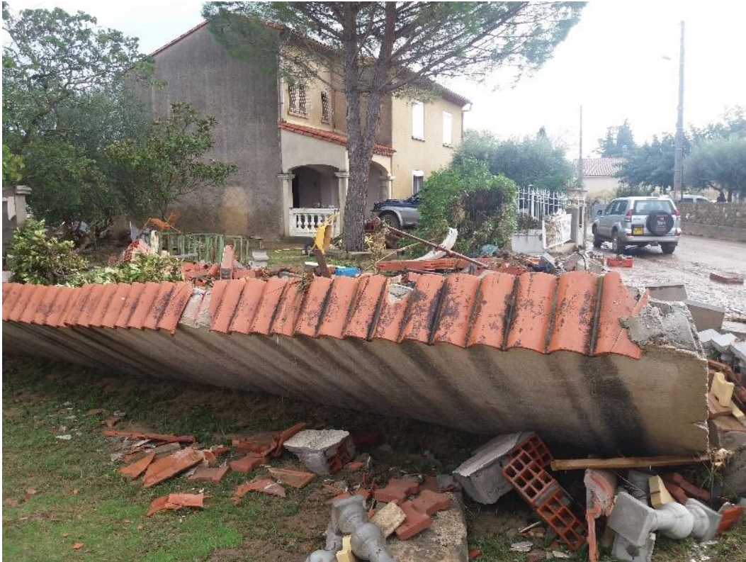
Dégâts causés par la crue de l'Aude en 2018 © SMMAR
