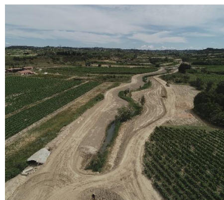
Le Briançon restauré en phase chantier
