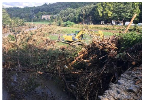
Intervention post crue d'urgence Crue de septembre 2020 (Cévennes)
