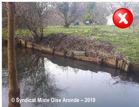
Protection d'une berge inadaptée
