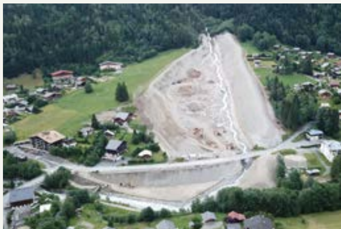
Ouvrage de régulation des apports solides sur le nant d'Armançette - Les Contamines-Montjoies
