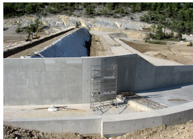
Barrage de Saint-Geniès-de-Malgoirès en construction
