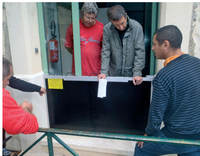
Pose d'un batardeau devant la mairie de Ners
