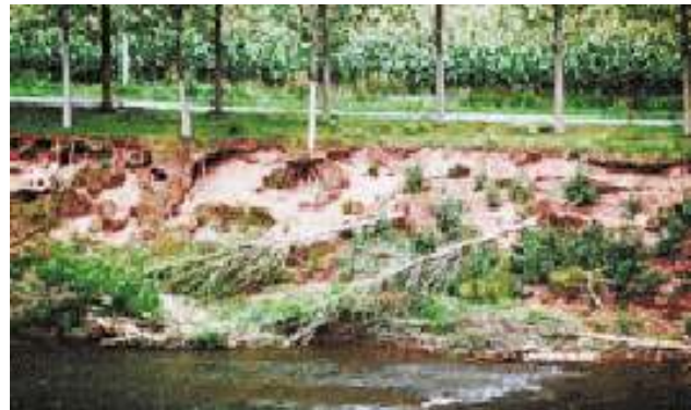
Erosions de berges (essences à faible enracinement)
