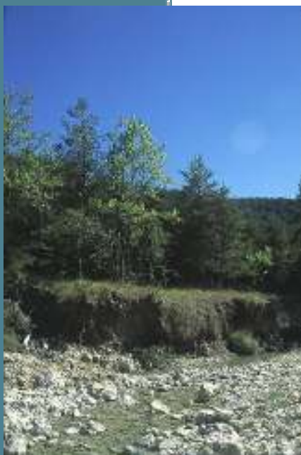
Erosion de berge sur le Jabron
