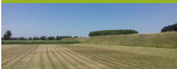
Digue proche de Marmande (Cerema)
