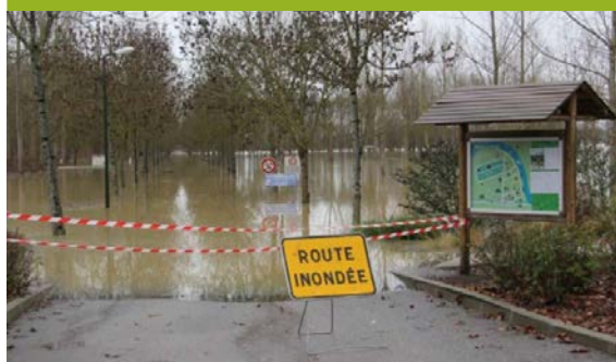
Inondation 2014 à Marmande (©sudouest)
