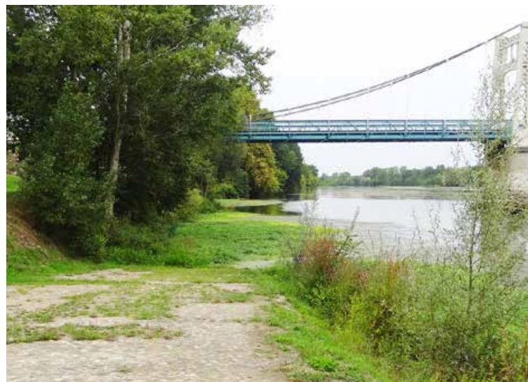
■ La Garonne à Auvillar (Tarn-et-Garonne), cale de l'ancien port restaurée Pascale Cornuau / DREAL Occitanie
