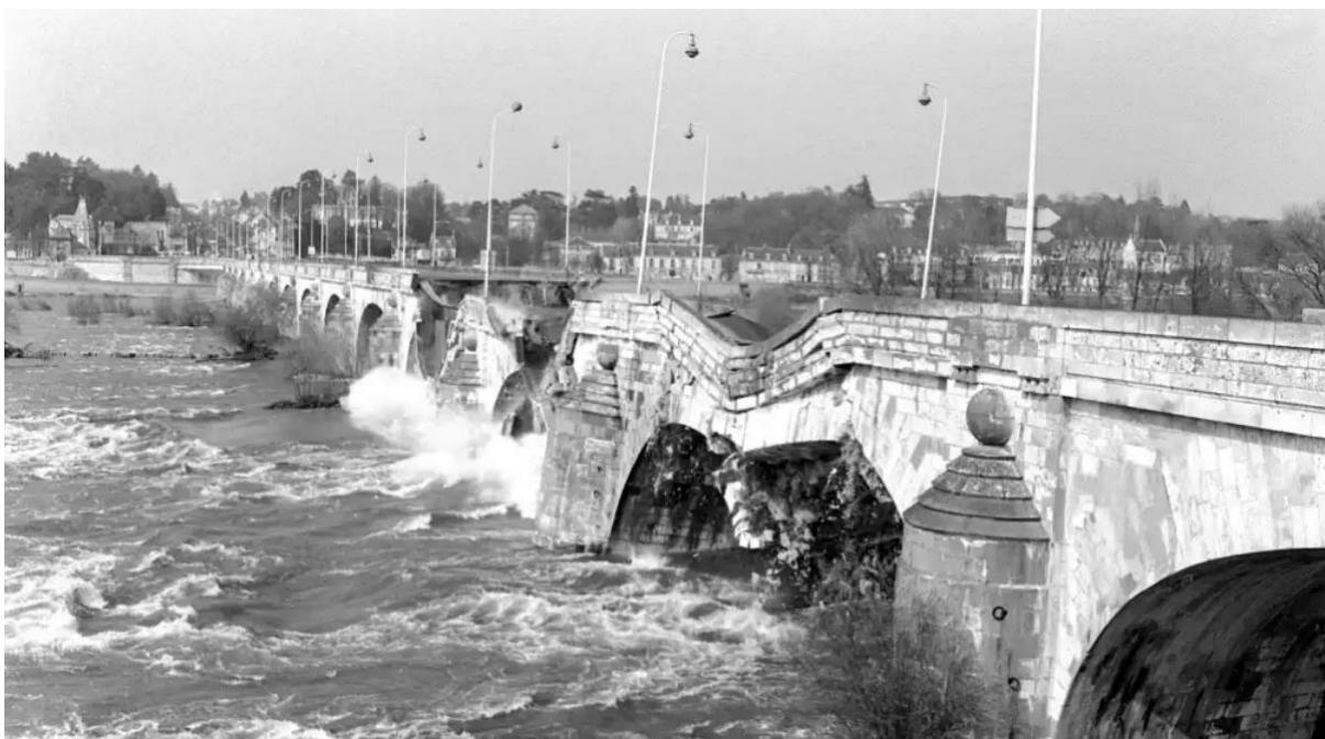
Photo © Second effondrement du pont Wilson à Tours en 1978, Pierre Fitou
