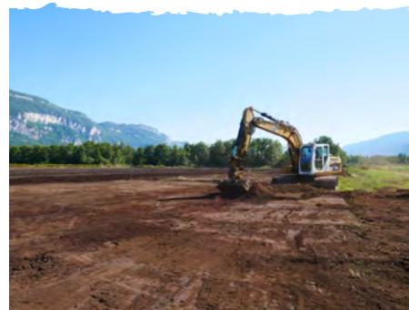
1 Extraction des matériaux de surface avec une pelle marais
