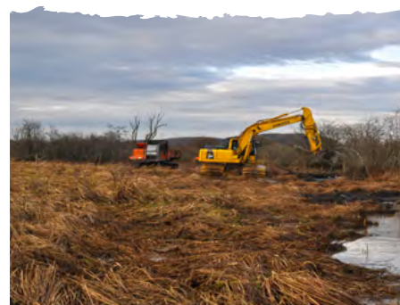
4 Photo des travaux de terrassement d'une baissière
