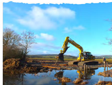
2 Photo des travaux de création de bouchons sur les drains
