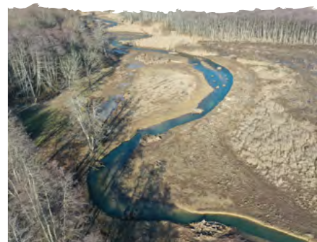
1 Travaux de réhabilitation environnementale des Rousses
