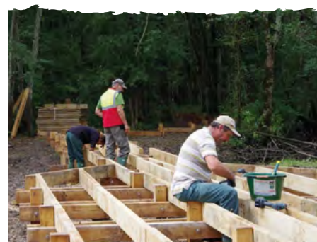
3 Construction du sentier sur pilotis
