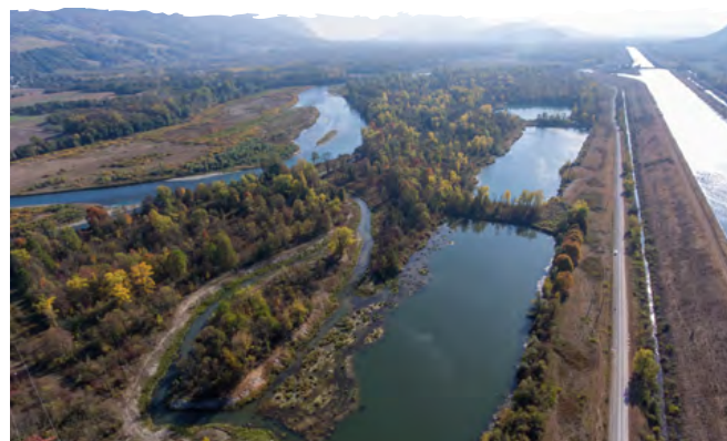
Vue aérienne du site après les travaux
