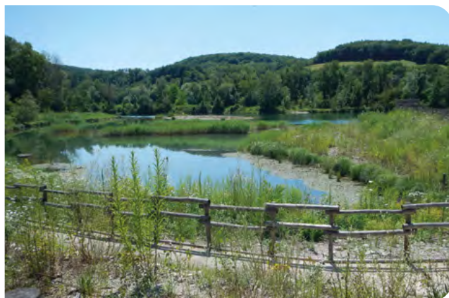
Plan d'eau n°3 après travaux : arasement d'îlot, reprofilage des berges en pente douce, création de hauts fonds
