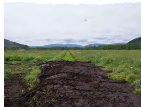
2 Drain en cours de comblement
