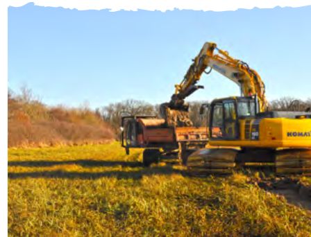
1 Photo des travaux de reméandrement
