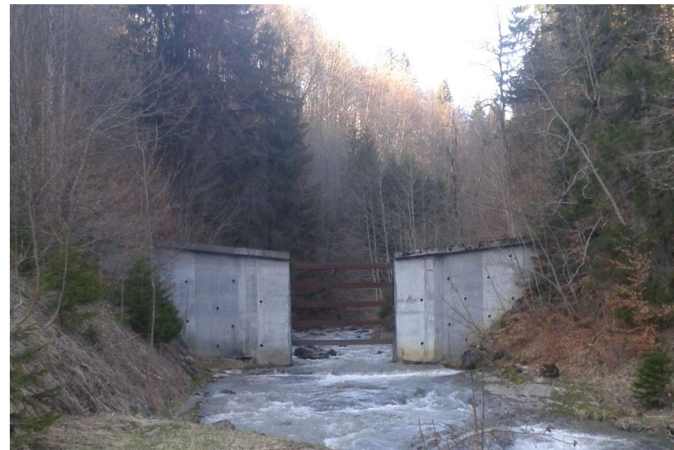
Création d'une plage de dépôt sur le torrent du Chinailon
