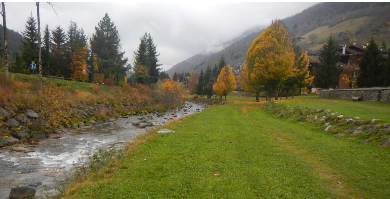
Recalibrage du lit dans le secteur du camping sinistrée
