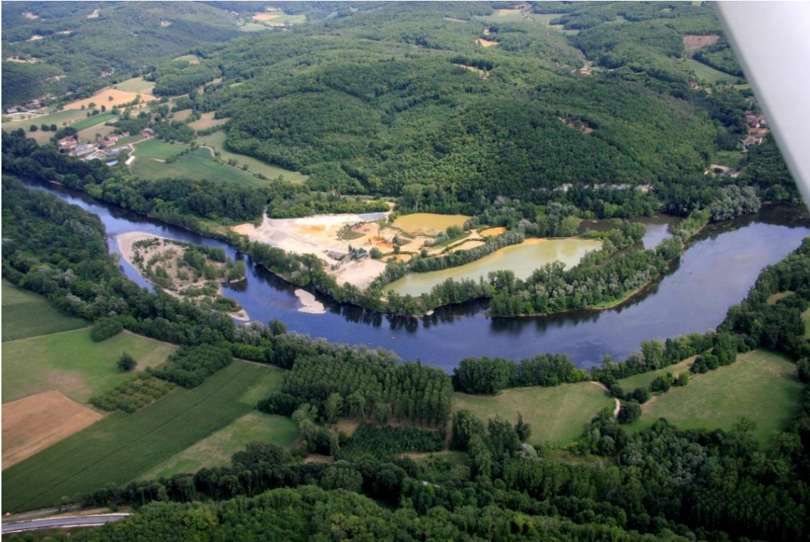
Gravière de Veyrignac (avant travaux)
