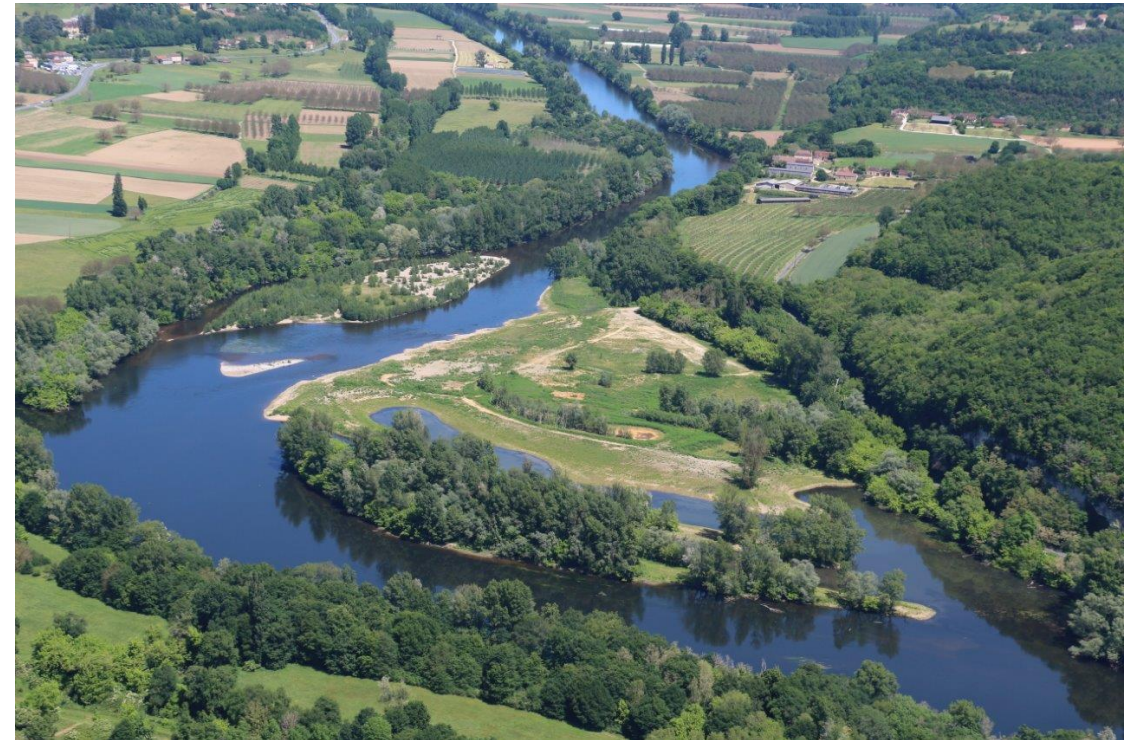
Gravière de Veyrignac (après travaux)
