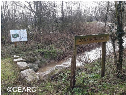
Déversoir d'un champ d'expansion de crue
