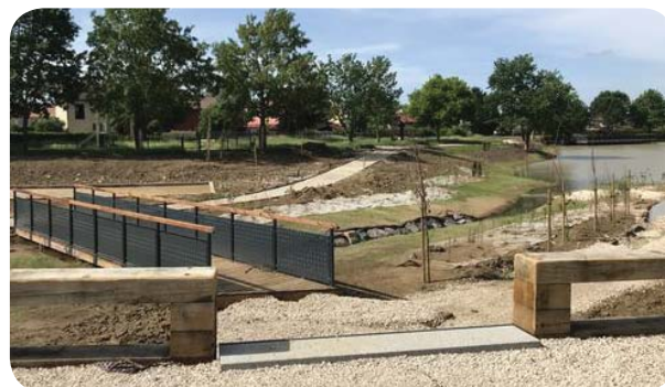
Les berges du plan d'eau ont été redessinées et revégétalisées. Elles sont en pente douce avec des terrasses sur pilotis et un espace vert en paliers. Source : Ville de Pulnoy
