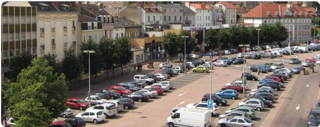
La place Leclerc est l'exemple type d'une surface de stationnement en revêtement imperméable - Longwy-bas (54)
