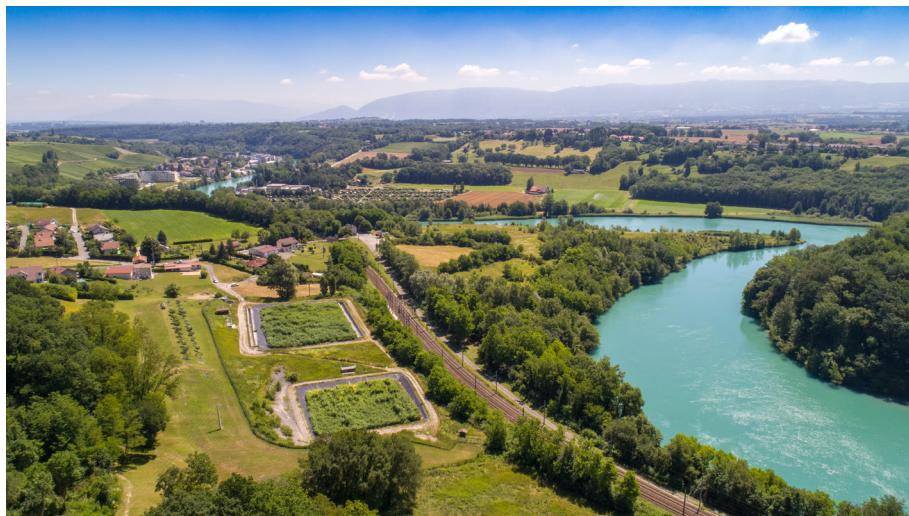
©Régie des eaux Gessiennes - Filtre planté de roseaux de Challex
