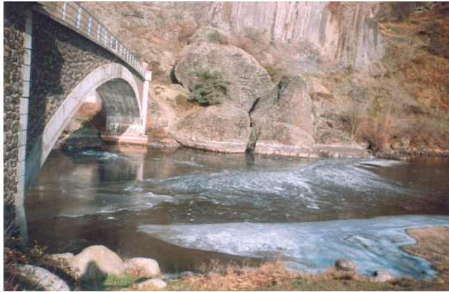
Pont de Prades
