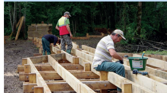
3 Construction du sentier sur pilotis.
