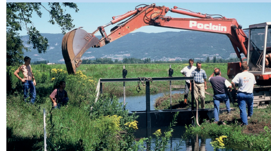
1 Installation d'une vanne pour une meilleure gestion des niveaux d'eau.
