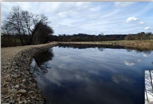
Vue sur le barrage mis aux normes
