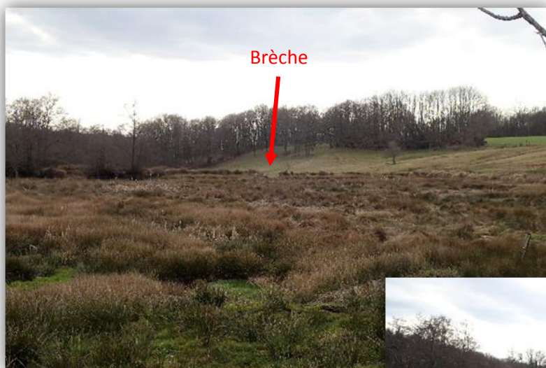
Vue en amont de l'ancien barrage
