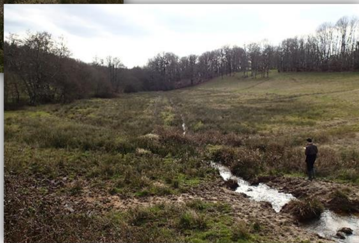
Vue en aval de l'ancien barrage
