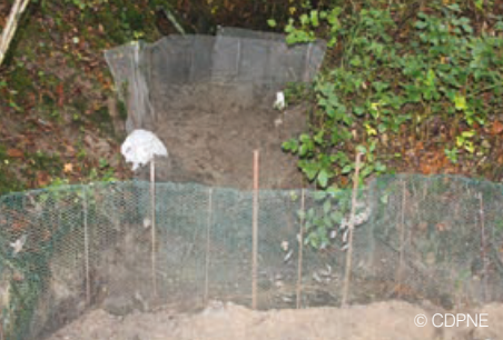
Pose de grilles de protection avant vidange
