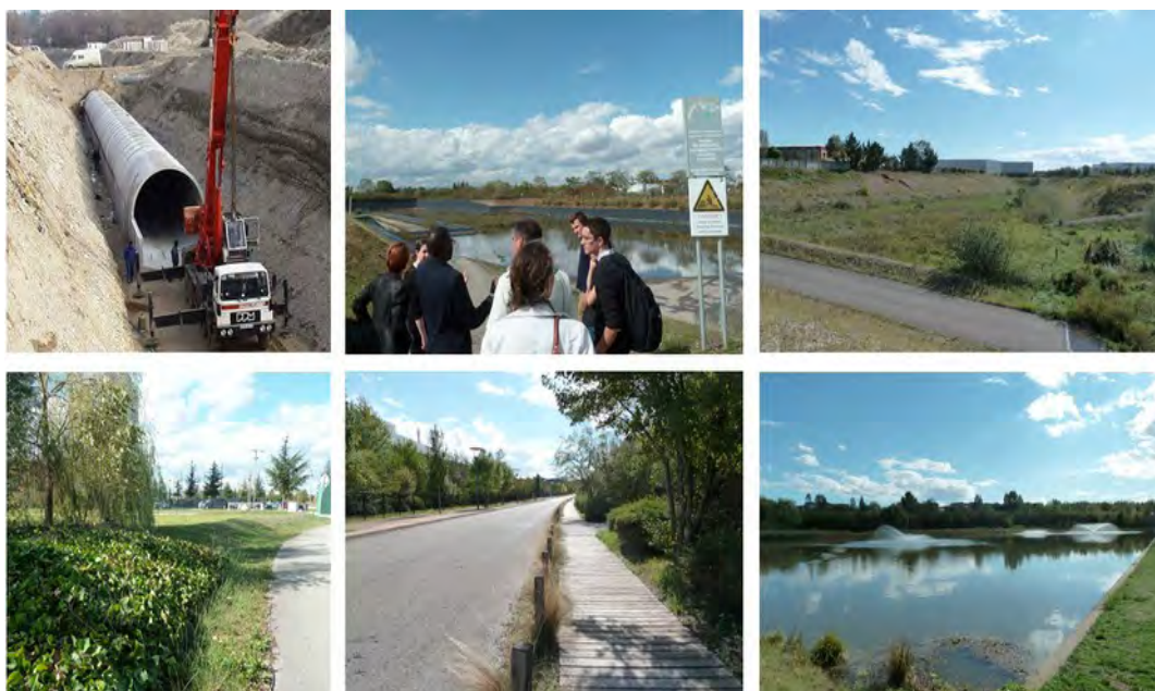
Figure 39: Exemples d'ouvrages sur le territoire du Grand Lyon, visités lors de la table ronde sur les grandes opérations d'urbanisme, le 18 septembre 2015 (sauf le collecteur) : collecteur d'eaux pluviales, bassins de rétention et d'infiltration au sein de la zone industrielle de Chassieu, noue végétalisée, noue surmontée de caillebotis et plan d'eau au sein de Portes des Alpes dans l'Est lyonnais (Ph. Grand Lyon et Cerema).
