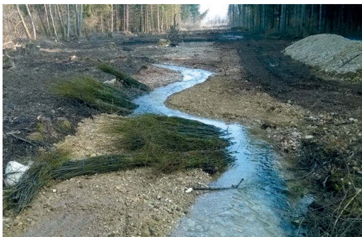
■ Après les travaux : le lit est plus sinueux et plus étroit.
