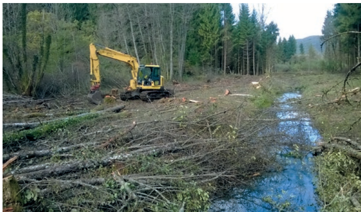
■ Le bief de Dessous-Roche pendant les travaux : le cours d'eau est encore rectiligne mais des épicéas sont abattus pour permettre sa divagation.
