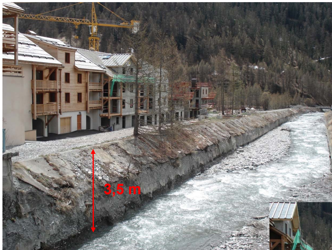
Digue mixte RG sur le torrent du Bouchet, affluent du Guil
