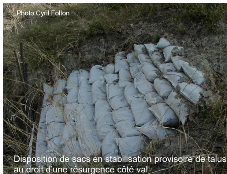
Figure 5.3 : Disposition de sacs en stabilisation provisoire de talus au droit d'une résurgence côté val
