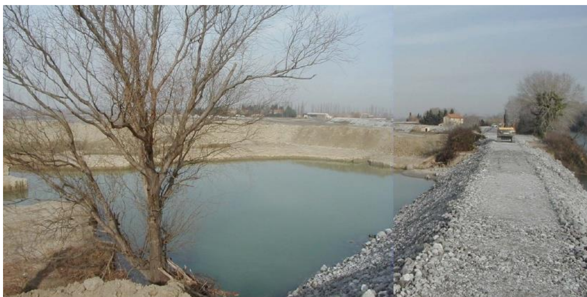
Figure 5.5 : Vue panoramique des remblais de fermeture en crue et post-crue de la brèche de Claire-Farine (Petit Rhône rive droite, décembre 2003)- Photo P. Mériaux, Irstea.
