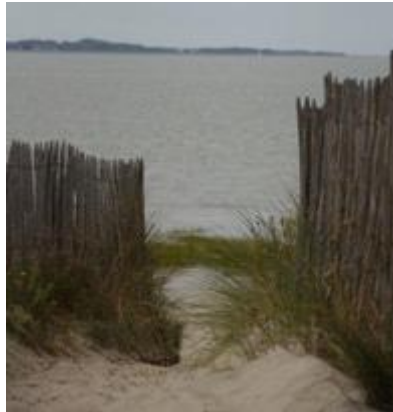
Ganivelles destinées à protéger des zones dunaires et à limiter un passage
