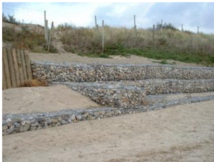
Exemple de gabion de galets
