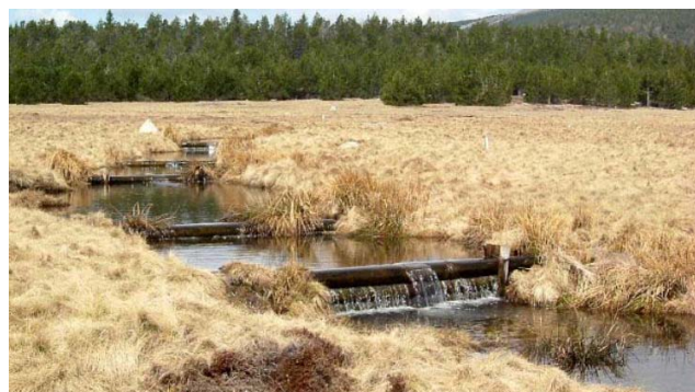
Photo 15- Travaux de restauration de la tourbière de la Sénégrière ( © PN Cévennes)
