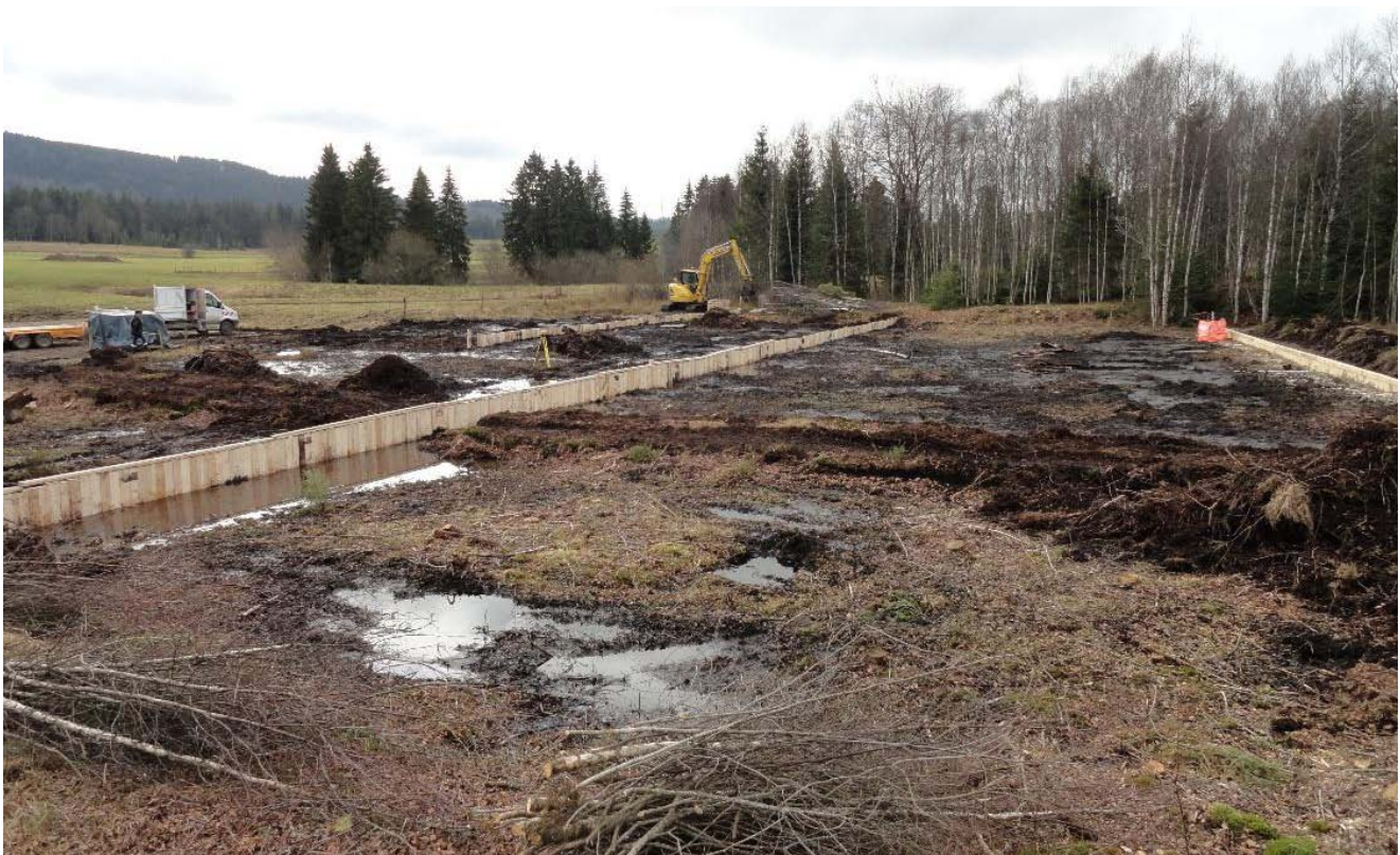
Photo 7 - La restauration hydrologique, lorsqu'elle est possible, des tourbières exploitées de façon industrielle nécessite des travaux de grande envergure. Ici la tourbière de Frambouhans (Doubs) et les travaux réalisés dans le cadre du Programme Life Tourbières du Jura (© G. Bernard)
