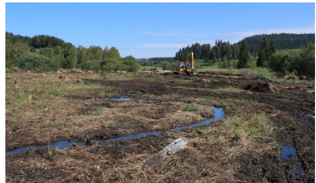
Photo 21 - Travaux de restauration du fonctionnement hydrologique du marais du Châtelet (Saint-Laurent-en-Grandvaux, 39). Le reméandrement de la Lemme permet d'améliorer l'alimentation en eau de cette tourbière (© F. Muller)
