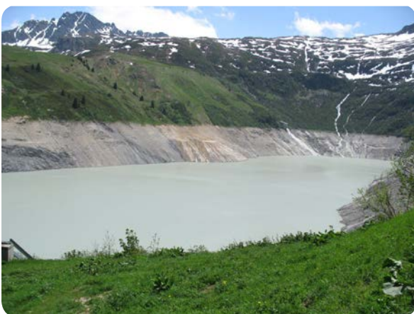
Retenue de la Girotte (73) – MEFM de haute montagne
