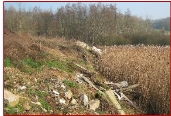
Figure 3 : destruction d'une zone humide par remblais, en Meurthe-et-Moselle (photo : S. Gueugneau).
