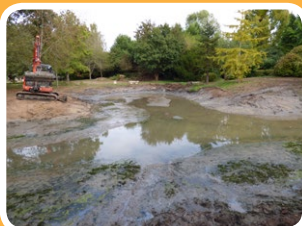
Les mares de Saint-Jean-de-Rebervilliers (en haut) et de Saint-Piat (en bas), pendant les travaux.
