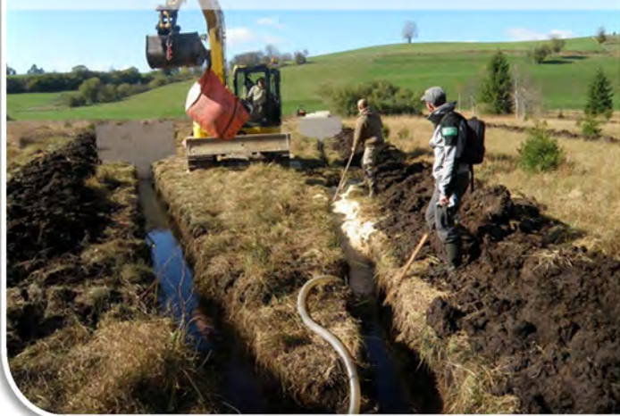
Suppressions de drains avec pose de panneaux de bois et remplissage avec de la sciure dans un bas marais du Doubs.
