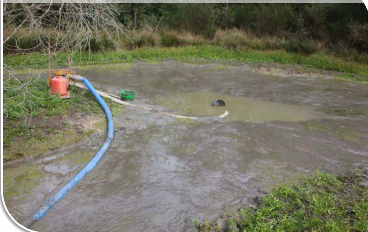
Pompage d'une mare avant curage.
