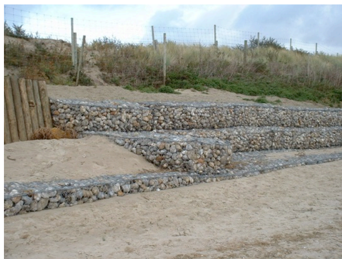
Figure 66 : exemple de gabion de galets
