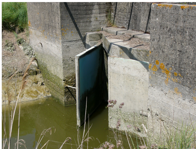
Figure 82 : une porte à flot à marée descendante
