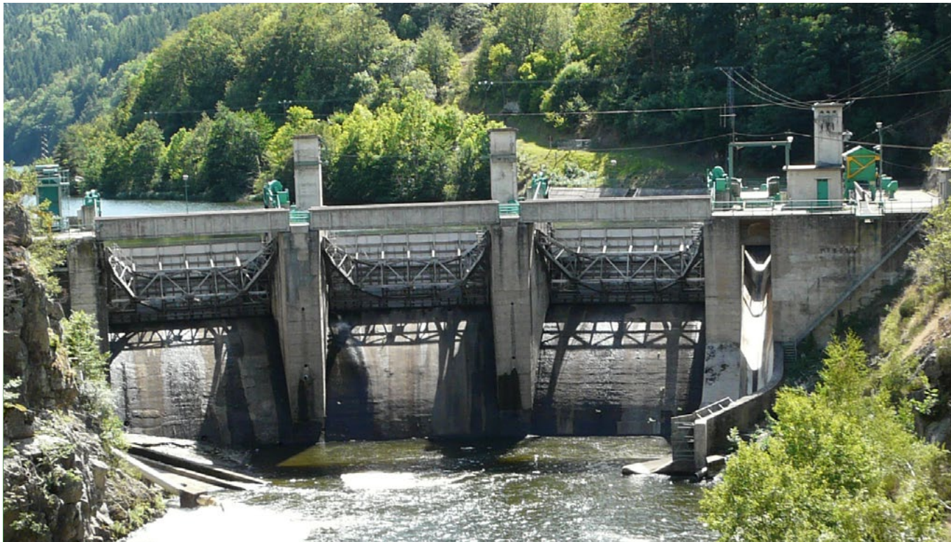
Photo du barrage de Poutès-Monistrol - si les saumons arrivent à franchir l'échelle ils gagnent le droit de prendre l'ascenseur © ONEMA
