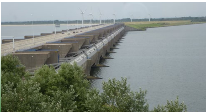
L'exutoire du Rhin dans la mer du Nord à travers les 17 colossales écluses du Haringvliet près de Rotterdam © Jean Wencker, juillet 2013
