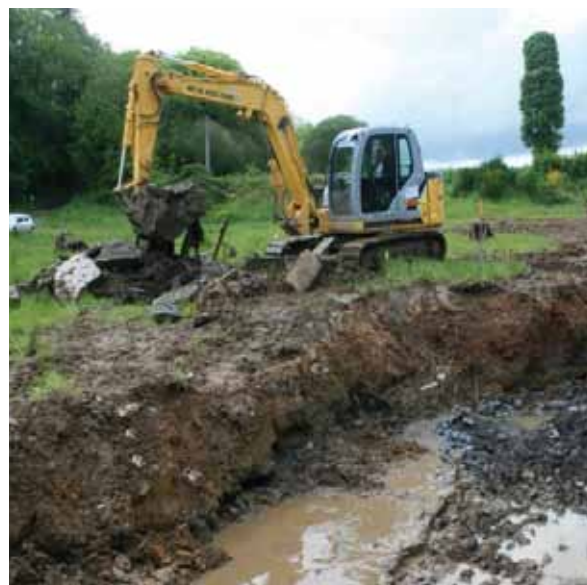
Exemple de suppression de remblai sur le site de réhabilitation de Corroac'h-plomelin (expérimentation) - Source : FMA, 2014
