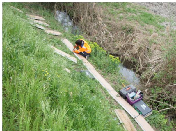
Assemblage des éléments sur la berge avant leur mise en place dans l'ouvrage
