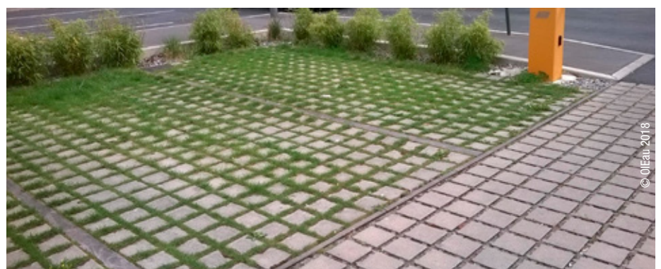
Parking perméable, exemple de MNRE en contexte urbain.
