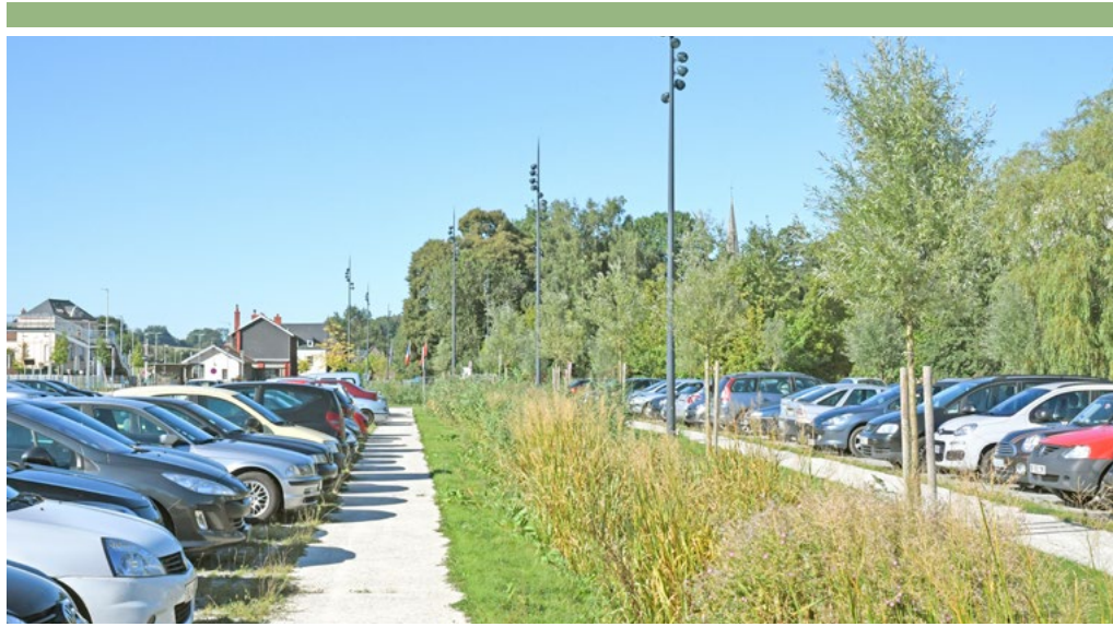
Noue humide - Gare D'Auffay (76) - © QUATREVIINGTDOUZE
