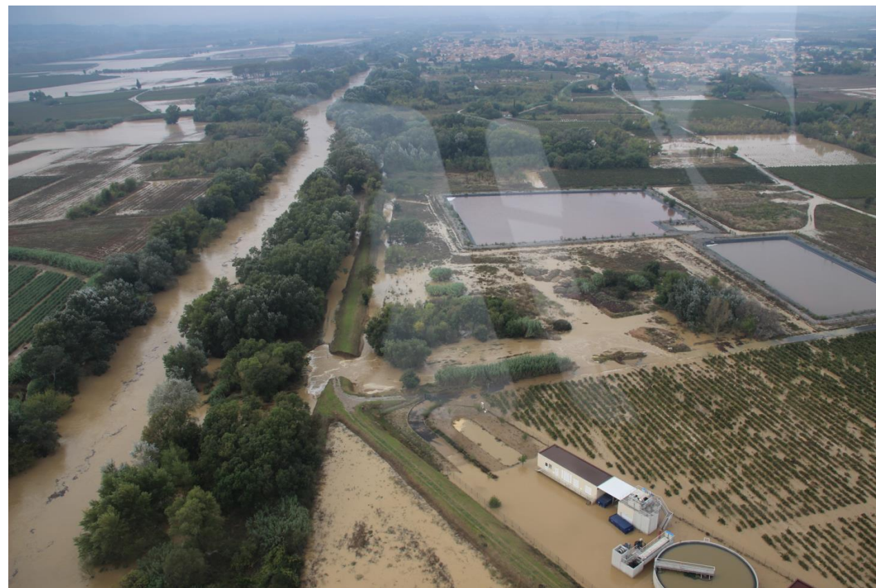
Brèche digue de bord d'Aude
