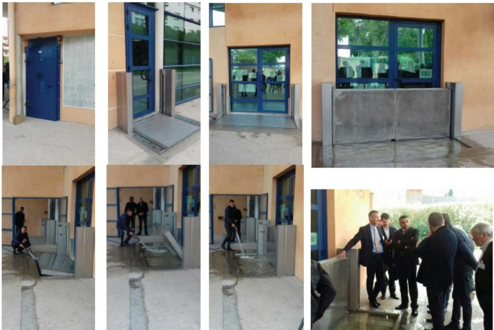
Présentation et démonstration des systèmes de protection (batardeaux automatiques et portes étanches) de l'école Marie-Curie à Mandelieu-la-Napoule (photos MIIAM - DREAL PACA)
