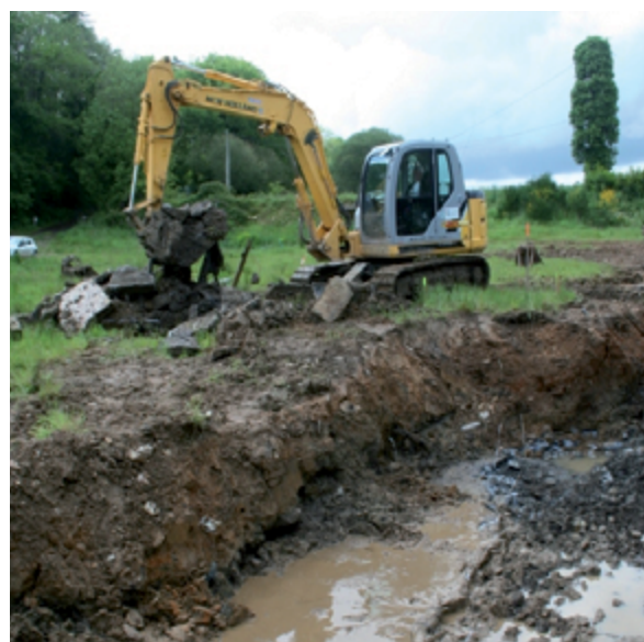
Exemple de suppression de remblai sur le site de réhabilitation de Corroac'h-plomelin (expérimentation) - Source : FMA, 2014
