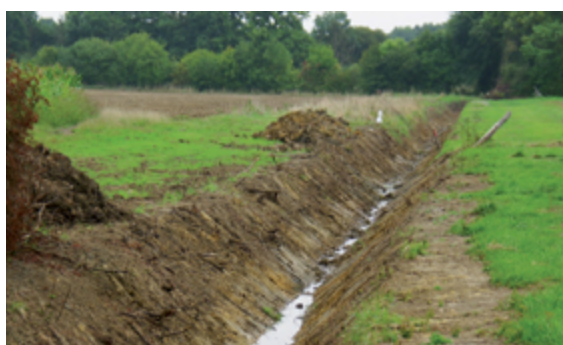
Exemple de suppression de drain - Source : CAMA
